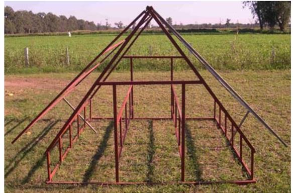
Figura 1.1.14: Alpina tipo INTA–estructura
